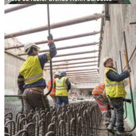
Pose du radier avenue Henri Barbusse
