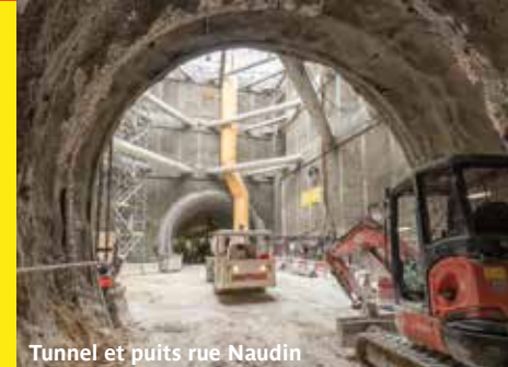
Projection de béton
